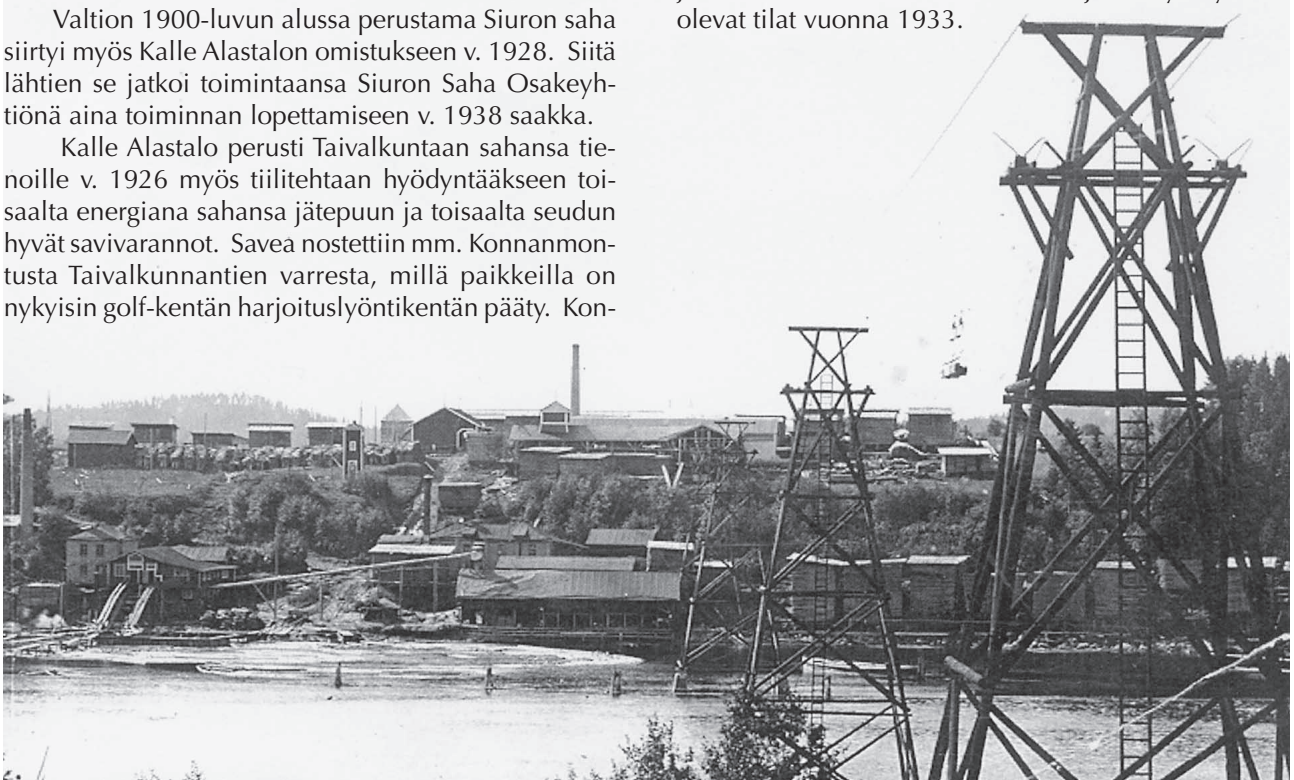
Tehtailija Kalle Alastalon tuotantolaitokset Nokianvirran etelätöyräessä. Paikalta löytyy nykyisin enää joitakin hajanaisia rakennuksen perustuksia ja ilmaradan sammaloituneita betonisia tukiarkkuja.
