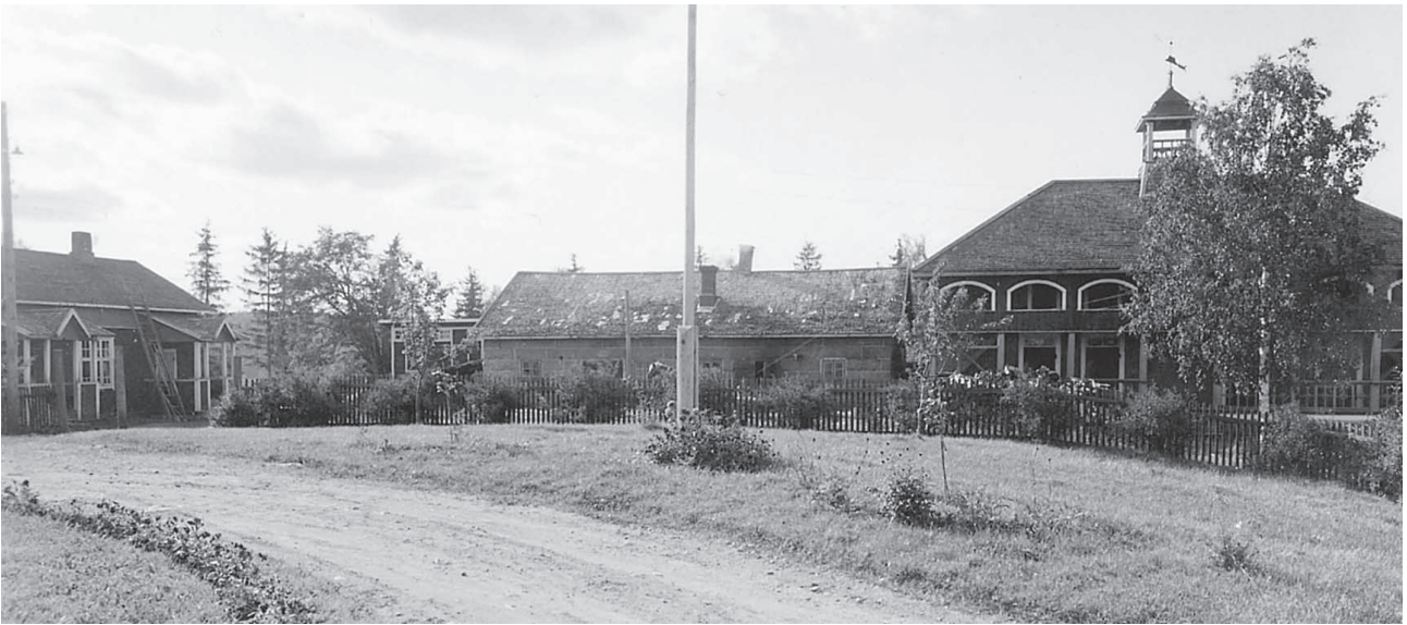
Vielä 1960-luvulla Alastalon pihapiirissä olivat käytössä kaksi työväen asuntoa ja leivintuvan käsittävä väenpirtti (vas.), harmaa kivinavetta ja komea aittarakennus, joka paloi maan tasalle pikkupoikien tulitikkuleikin seurauksena v. 1993. Näiden rakennusten paikalla on nyt golf-kentän pysäköintialue.
