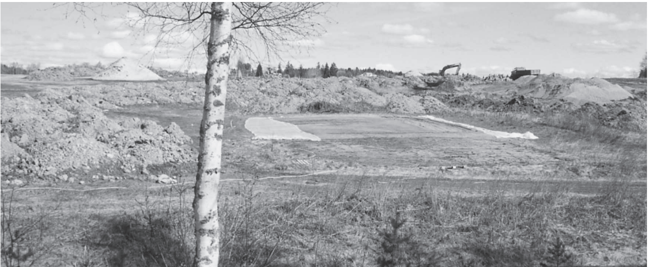
Rakentamisen alkuaikoina oli aikamoinen mylläkkä niin kenttätömaalla kuin taivalkuntalaisten mielissäkin.
